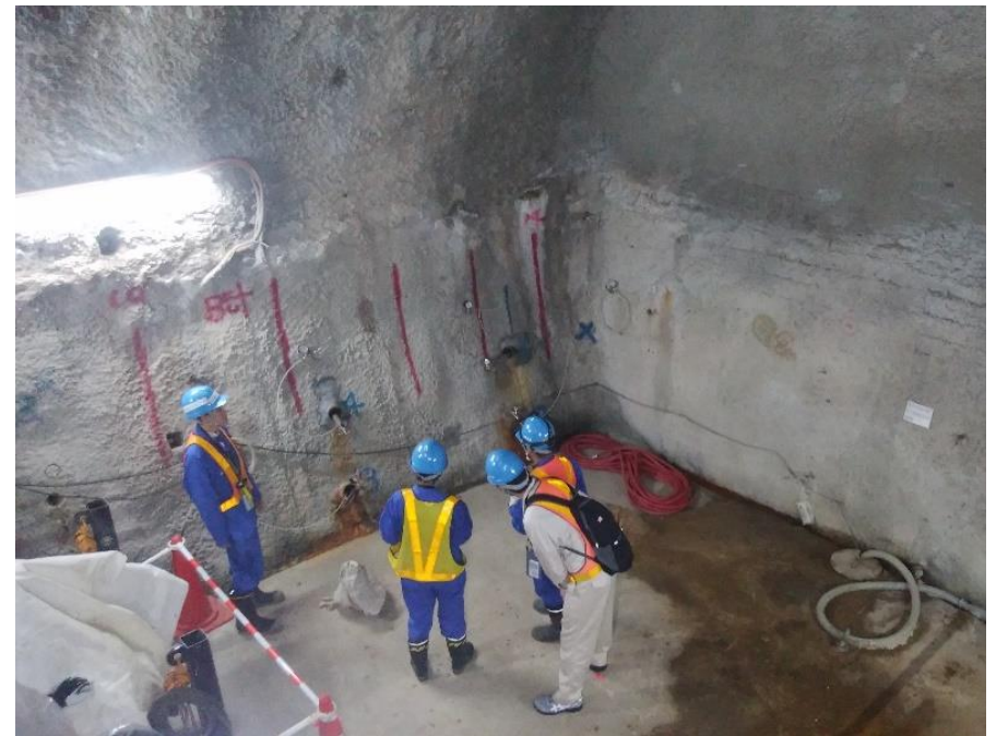
写真 現場確認の状況 (250m西立坑側第1ボーリング横坑)
