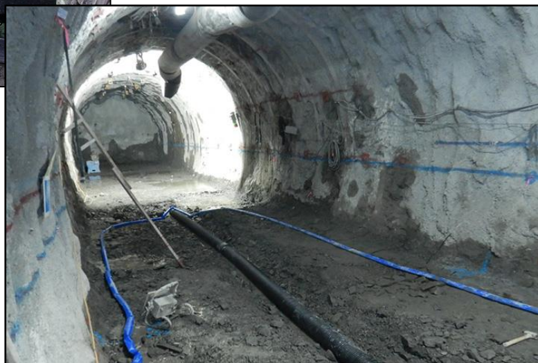
試験坑道6の掘削完了
