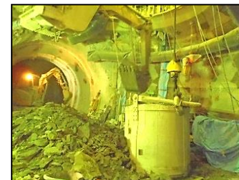
③掘削土(ズリ)出し
